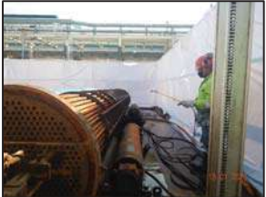
รูปที่ 6.5 ฉีดพ่นน้ำยาขณะถอดอุปกรณ์ออก
